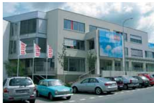
IN DER NEUEN ZENTRALE DER AVE TSschechien IN PRAG WERDEN UMFANGREICHE SYNERGIEN NACH DER REMONDIS-ÜBERNAHME GENUTZT.
