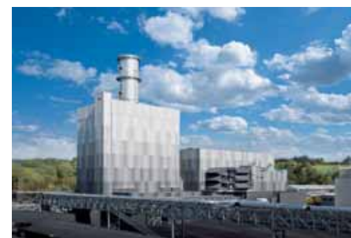
DAS GAS- UND DAMPFKRAFTWERK TIMELKAM IST DIE GRÖSSTE ENERGIEEFFIZIENZMASSNAHME IN DER GESCHICHTE OBERÖSTERREICHS: PRO ERZEUGTER KILOWATTSTUNDE STROM WIRD DER CO 2 -AUSSTOSS UM 66 PROZENT REDUZIERT, DER NO x -AUSSTOSS UM FAST 90 PROZENT.
