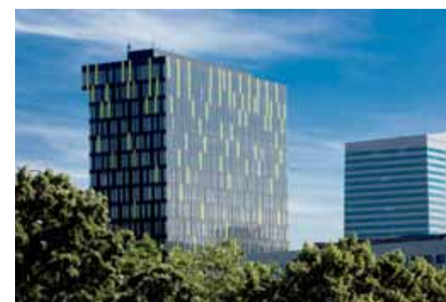
ENERGIE ZUM HEIZEN UND KÜHLEN WIRD IM POWER TOWER MITTELS WÄRMEPUMPEN AUS DER ERDE GEWONNEN. DIE KONSEQUENTE UMSETZUNG DIESES KONZEPTEES IST EIN MEILENSTEIN DER NACHHALTIGKEITSPHILOSOPHIE DES KONZERNES.
